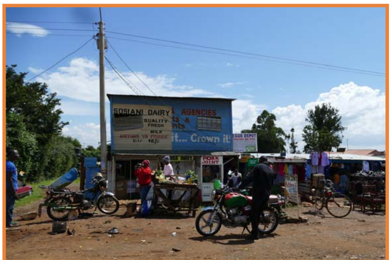
In Städten, wie hier in Eldoret in Kenia, gibt es ein Netz aus Stromleitungen. Darüber können sich auch Firmen mit Elektrizität versorgen, wie dieses kleine Milchgeschäft.
